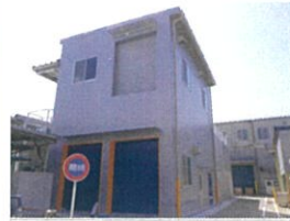
豊生フレイキ工業㈱ 管理棟新築工事
