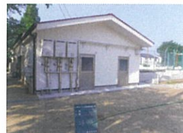
大府市立大府中学校プール棟改修工事
