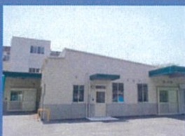
大府市立神田小学校給食室改修工事 (外壁・屋根・給食設備 400㎡)
