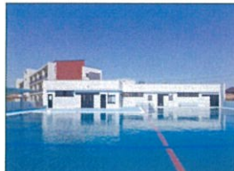
大府市立大東小学校プール建設
