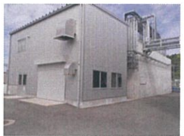
豊生フレイキ工業㈱ 管理棟新築工事
