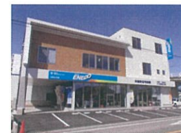
㈱富新住宅設備事務所新築工事
