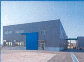
㈱近畿コム工業所工場新築工事 (5.5畓2階建 総床面積 9,033.39 m 2 )
