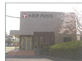
トミタパックス㈱本部事務所新築工事
