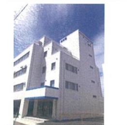
㈱朝日機器エンジニアリング 倉庫棟新築工
