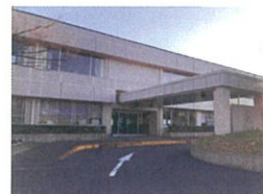
大府市健康管理センター改修工事(外壁修繕工)
