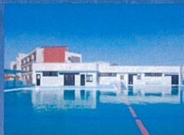
大府市立大東小学校プール建設 (FIC 造)
