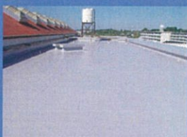
大府市立石ヶ崎小学校屋上防水工事
