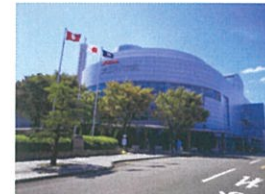
大府市愛三文化会館改修工事(外壁改修他)
