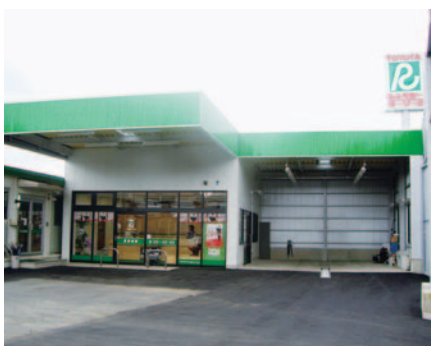
店舗新築工事
