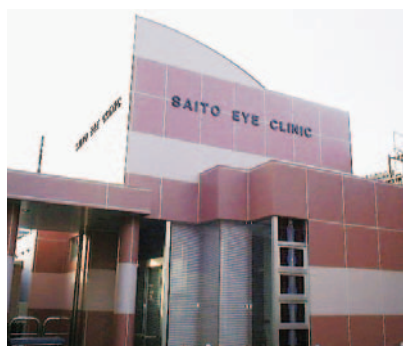
医院新築工事
