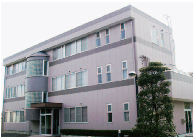
オフィスビル新築工事
