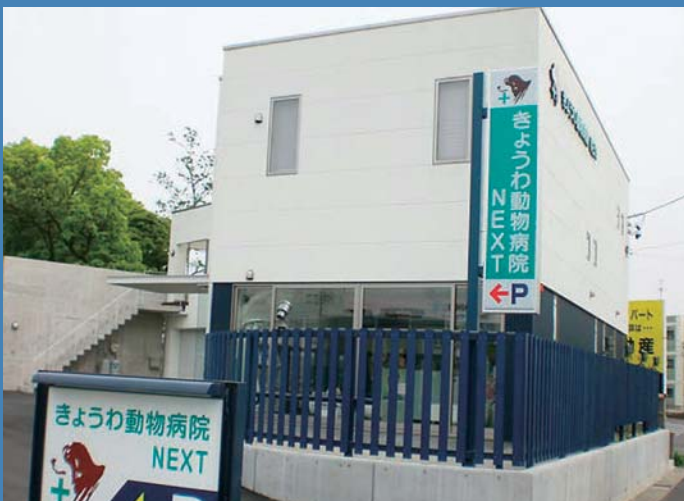
きょうわ動物病院（鉄骨造 2階建 延床面積 268.47㎡）
