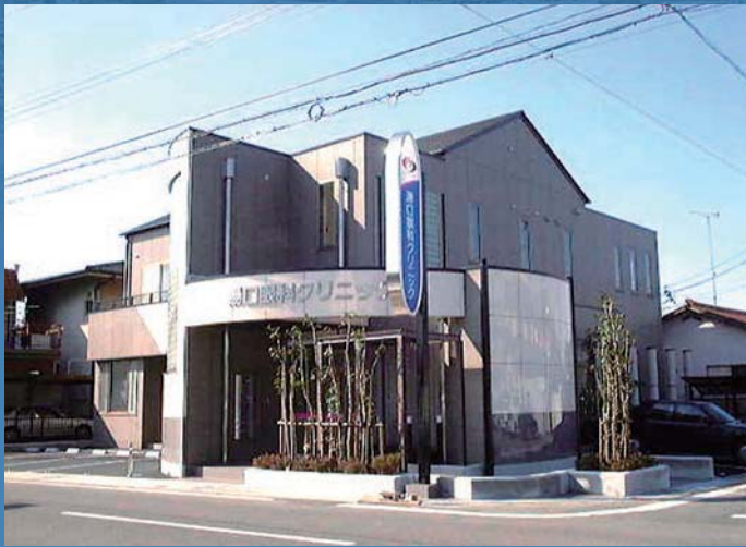
湯口眼科クリニック（鉄骨造 2階建 延床面積 375.36㎡）
