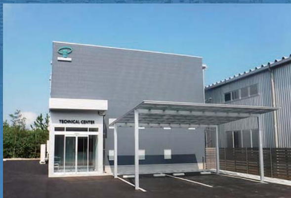
㈱ケーアールアイ技術棟新築工事 (S造2階建 延床面積 316.32㎡)
