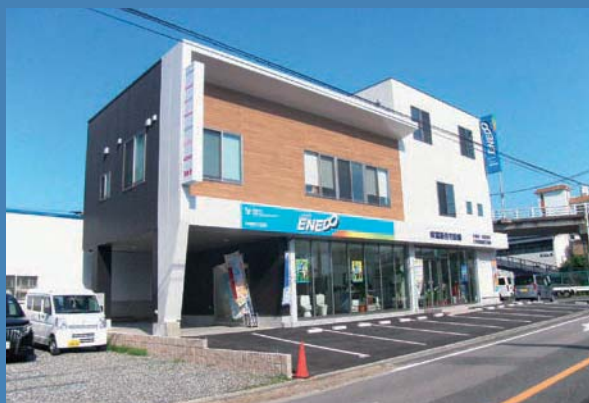
㈱富新住宅設備事務所ショールーム新築 (S造3階建 延床面積 325.5㎡)
