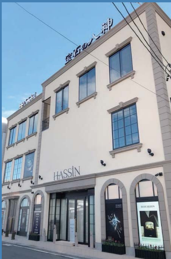
宝石の八神 店舗新築 (S造3階建 延床面積 855.68㎡)
