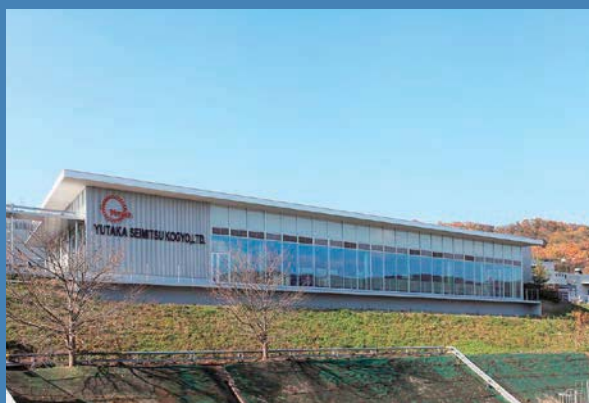
豊精密工業㈱みたけ工場食堂棟新築工事 (S造1階建 延床面積 750㎡) 42m×18m
