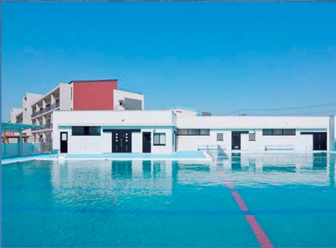
大府市立大東小学校プール建設 (RC 造)
