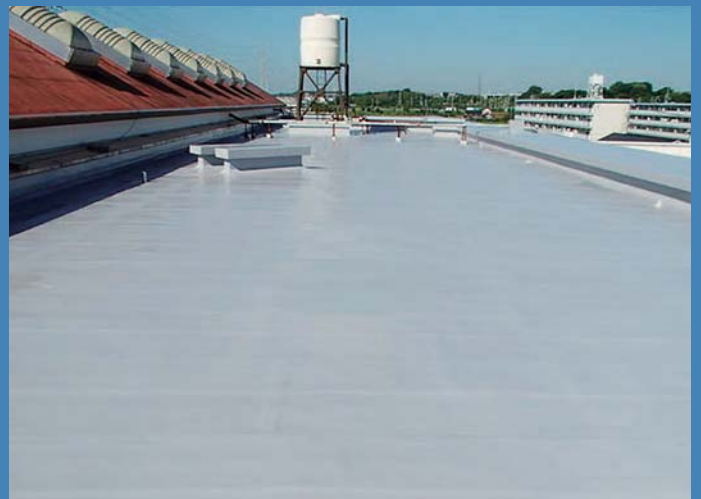
大府市立石ヶ瀬小学校屋上防水工事
