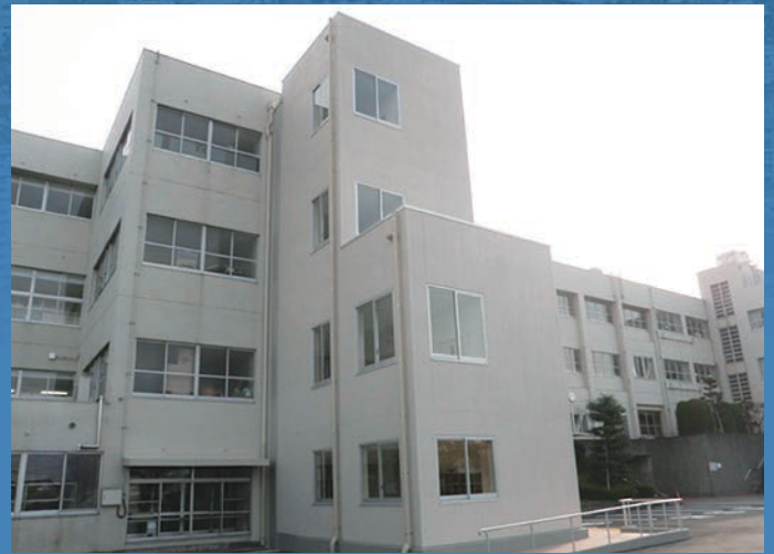
大府市立共和西小学校エレベーター棟増築 (RC 造)
